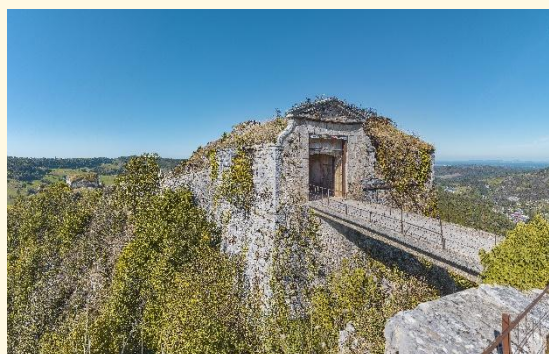
La redoute de Grelimbach du fort Belin à Salins-les-Bains © T. Kuntz, Région Bourgogne-Franche-Comté Inventaire du patrimoine, 2024
