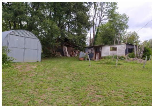
Figure 11 : Construtions de la « Cabane du Trappeur »
