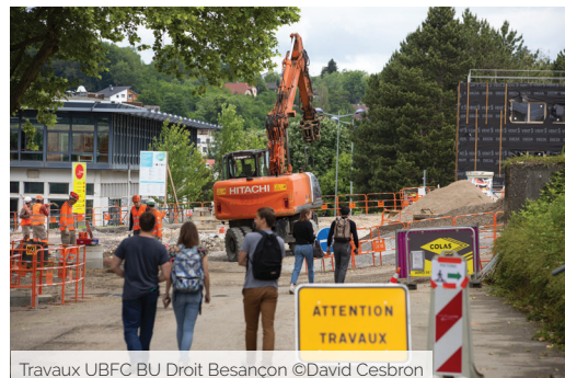
Travaux UBFC BU Droit Besançon ©David Cesbron
