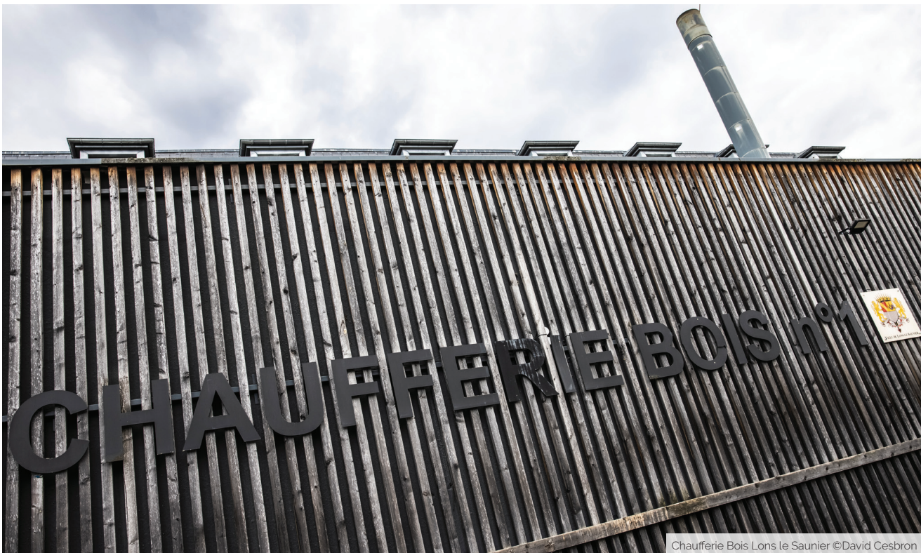
Chaufferie Bois Lons le Saunier ©David Cesbron
