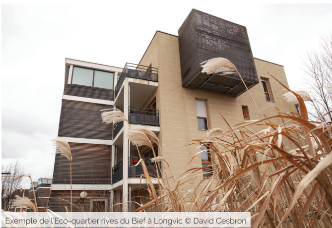
Exemple de l'Eco-quartier rives du Bief à Longvic © David Cesbron
