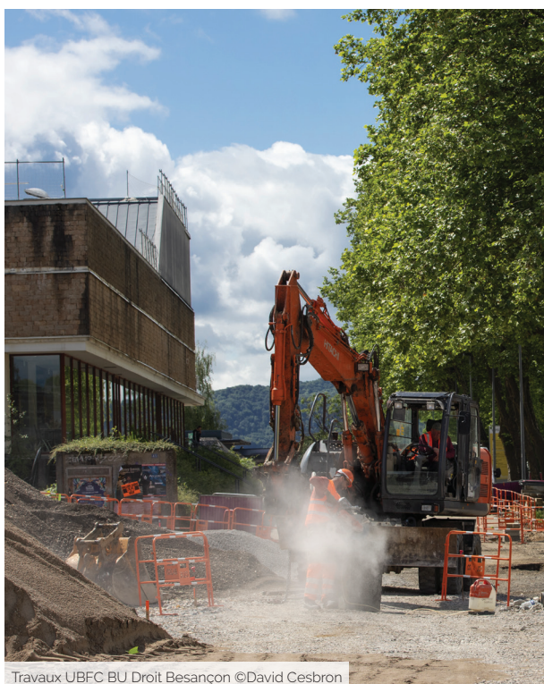
Travaux UBFC BU Droit Besançon ©David Cesbron
