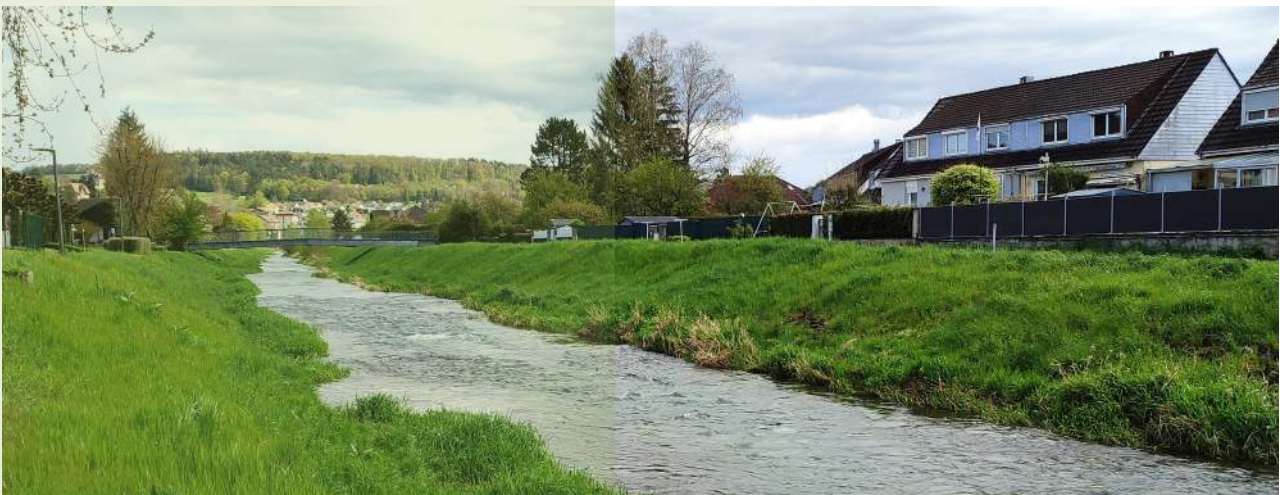
Restauration hydromorphologique de l'Allaine à Delle (90)
